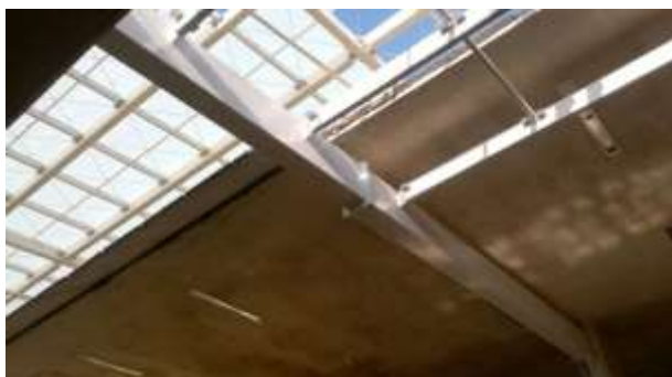
Figura 1 – Cobertura do aeroporto Tancredo Neves, MG, Brasil
