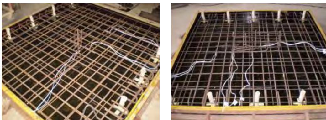
Figura 5: Instalação de extensômetros nas armaduras das lajes com índice 1 e 7
