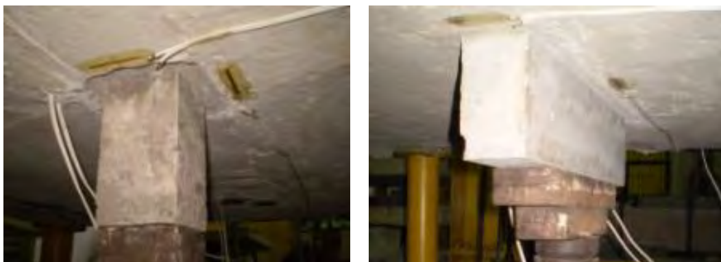
Figura 4: Instalação de extensômetros no concreto das lajes L1A e L4A
