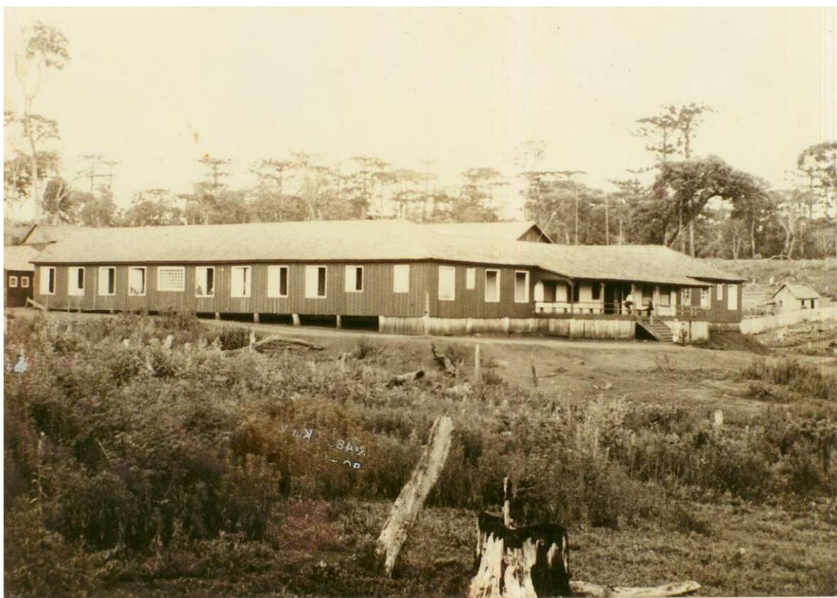
Figura 1. Pavilhão da CANGO – 1958, hoje instalações do Exército Brasileiro na cidade de Francisco Beltrão-PR. Fonte: Boletim de Inspeção da 5º RM/DI de 1958.
