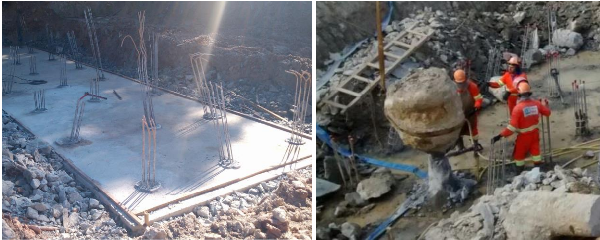
Figura 4 – (a) Vista geral bloco de estacas raiz , (b) aumento do diâmetro gerado pela aplicação de golpe de ar
